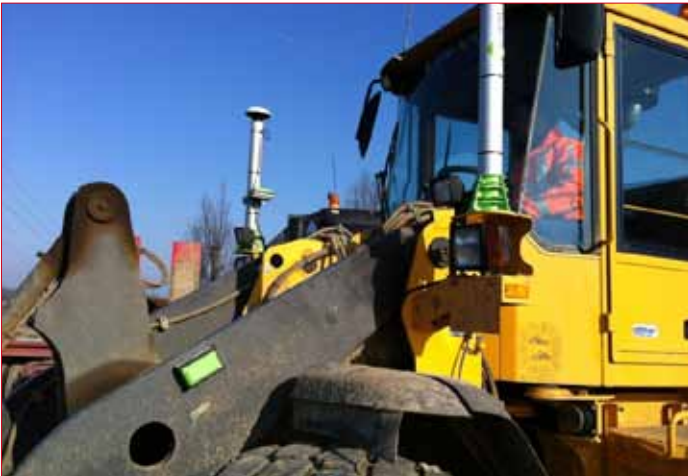
Zwei GNSS-Antennen auf dem Radlader
